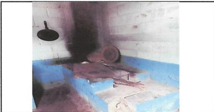
FOTO 5: ESTUFA EN MAL ESTADO, PLANCHA DETERIORADA, NO TIENE CHIMENEA Y DE BAJA ALTURA, NO HAY EXTRACCIÓN DE HUMO
