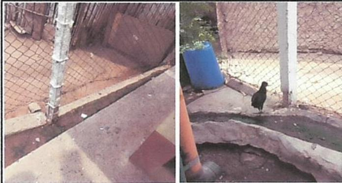
FOTO 3: NECESIDAD DE LEVANTAR MURO PERIMETRAL DE 4 HILADAS DE BLOCK + MALLA PORQUE INGRESAN ANIMALES DE CORRAL Y DE LA CALLE AL ESTABLECIMIENTO
