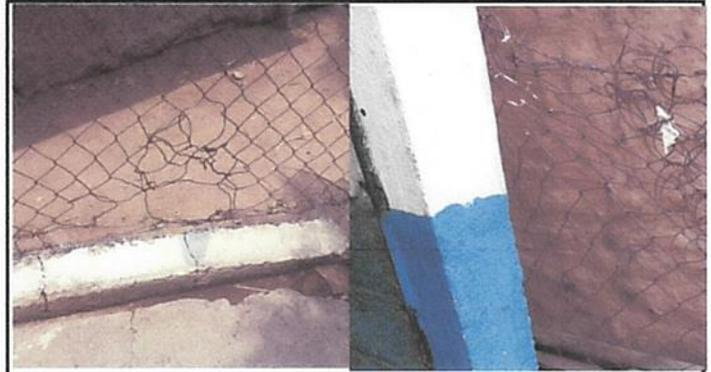
FOTO 4: MALLA GALVANIZADA EN MAL ESTADO NO PRESENTA SEGURIDAD A LA INSTALACIÓN
