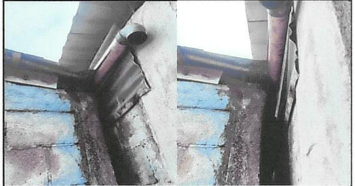
FOTO 2: NECESIDAD DE CAMBIAR LA PENDIENTE DEL TECHO YA QUE HUMEDECE LA PARED DEL AULA CONTINUA, DEBERÁ LEVANTARSE PARED
